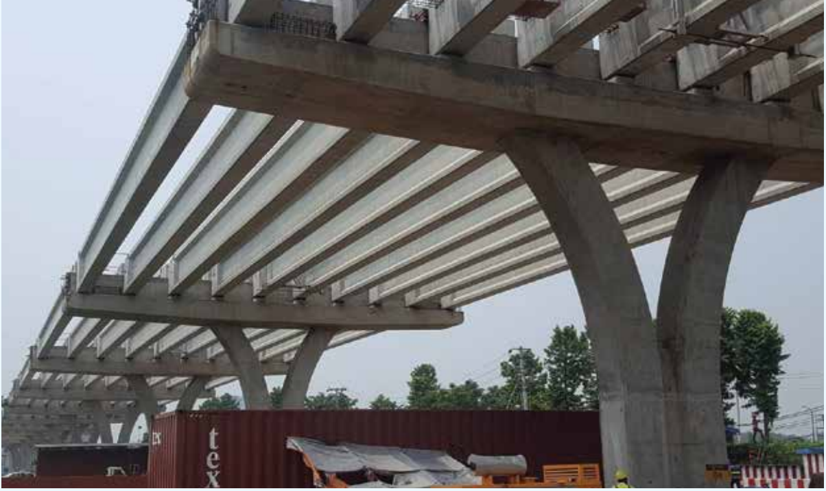
ঢাকা এলিভেটেড এক্সপ্রেসওয়ে পিপিপি প্রকল্প স্থাপিত আই গার্ডার ইরেকশন
