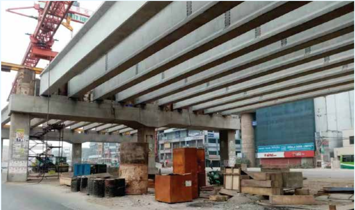
শ্বেটার ঢাকা সাসটেইনেবল আরবান ট্রান্সপোর্ট প্রজেক্ট (এলিভেটেড অংশ)-এর আই গার্ডার স্থাপন কার্যক্রম
